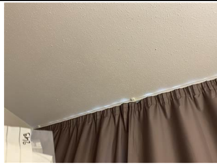
Photo n° PhA249 Localisation : 3ème étage - Logement 301 - Chambre Ouvrage : Plafond Description : Peinture + enduit blanc + béton gris Localisation sur croquis : 249 Amiante : Non détecté
