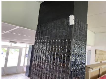
Photo n° PhA659 Localisation : Rez de chaussée - Hall foyer Ouvrage : Mur Description : Colle grise de faïence Localisation sur croquis : 659 Amiante : Chrysotile
