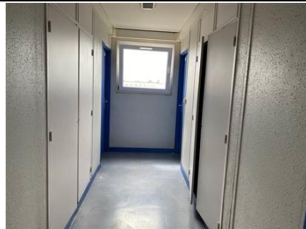
Photo n° PhA174 Localisation : 4ème étage - Dégagement Ouvrage : Mur de doublage Description : Peinture + plâtre blanc Localisation sur croquis : 174 Amiante : Non détecté
