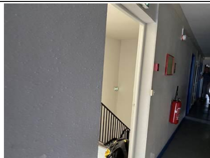
Photo n° PhA173 Localisation : 4ème étage - Dégagement Ouvrage : Mur de cloison Description : Peinture + plâtre blanc Localisation sur croquis : 173 Amiante : Non détecté
