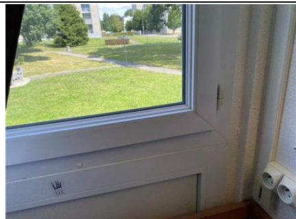
Photo n° PhA544 Localisation : 1er étage - Logement 101 - Chambre Ouvrage : Mur de doublage Description : Peinture + plâtre blanc Localisation sur croquis : 544 Amiante : Non détecté
