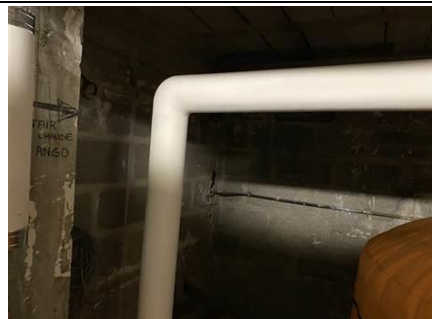
Photo n° PhA698 Localisation : Sous sol Ouvrage : Calorifugéage Description : Enduit blanc + plastique gris + fibre jaune Localisation sur croquis : 699 Amiante : Non détecté
