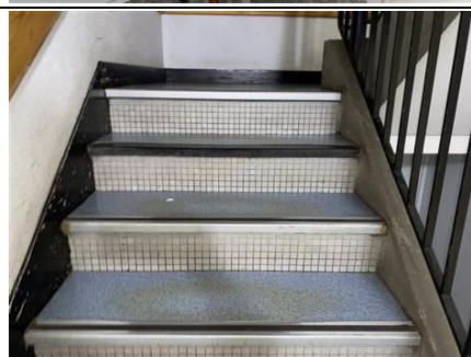
Photo n° PhA676 Localisation : Rez de chaussée - Escalier 1 Ouvrage : Mur Description : Colle grise de carrelage Localisation sur croquis : 676 Amiante : Non détecté
