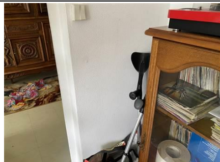
Photo n° PhA687 Localisation : Rez de chaussée - Logement gardien - Séjour Ouvrage : Mur porteur Description : Toile de fibres tissées peinte + enduit blanc + béton gris Localisation sur croquis : 687 Amiante : Non détecté
