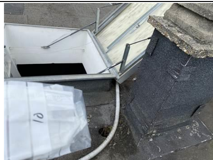
Photo n° PhA010 Localisation : Toit terrasse Ouvrage : Skydome Description : Revêtement bitumineux noir Localisation sur croquis : 010 Amiante : Non détecté
