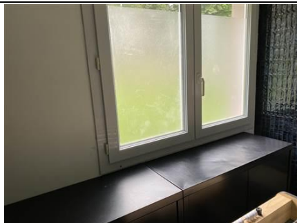
Photo n° PhA661 Localisation : Rez de chaussée - Hall foyer Ouvrage : Mur de doublage Description : Peinture + enduit blanc + plâtre blanc Localisation sur croquis : 661 Amiante : Non détecté
