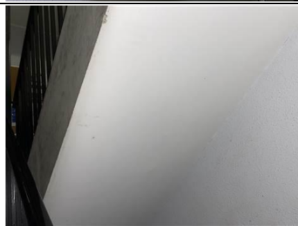
Photo n° PhA674 Localisation : Rez de chaussée - Escalier 1 Ouvrage : Paillasse Description : Peinture blanche + béton gris Localisation sur croquis : 674 Amiante : Chrysotile
