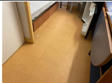
Photo n° PhA252 Localisation : 3ème étage - Logement 302 - Chambre Ouvrage : Sol Description : Dalle de sol souple + ragréage gris + béton gris Localisation sur croquis : 252 Amiante : Non détecté
