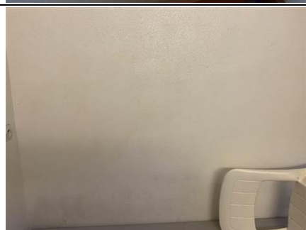
Photo n° PhA545 Localisation : 1er étage - Logement 101 - Chambre Ouvrage : Mur porteur Description : Peinture + enduit blanc + béton gris Localisation sur croquis : 545 Amiante : Non détecté
