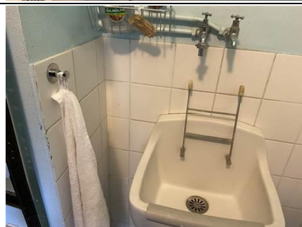
Photo n° PhA666 Localisation : Rez de chaussée - Hall foyer Ouvrage : Mur Description : Colle grise de faïence Localisation sur croquis : 666 Amiante : Non détecté
