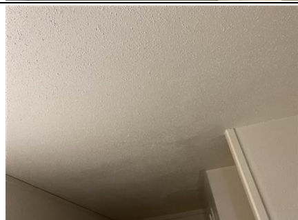
Photo n° PhA546 Localisation : 1er étage - Logement 101 - Chambre Ouvrage : Plafond Description : Peinture + enduit blanc + béton gris Localisation sur croquis : 546 Amiante : Non détecté
