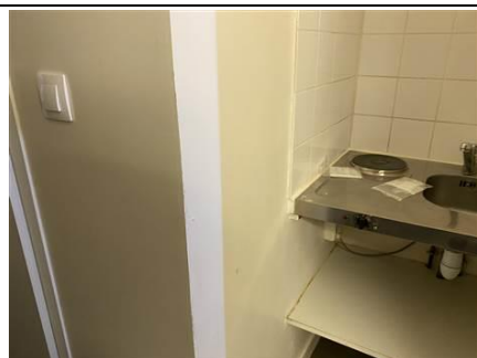
Photo n° PhA543 Localisation : 1er étage - Logement 101 - Chambre Ouvrage : Mur de cloison Description : Peinture + plâtre blanc Localisation sur croquis : 543 Amiante : Non détecté
