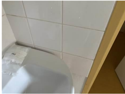
Photo n° PhA495 Localisation : 1er étage - Logement 123 - Chambre Ouvrage : Mur Description : Colle grise de faïence Localisation sur croquis : 495 Amiante : Non détecté
