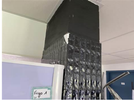
Photo n° PhA658 Localisation : Rez de chaussée - Hall foyer Ouvrage : Mur Description : Colle grise de faïence Localisation sur croquis : 658 Amiante : Chrysotile
