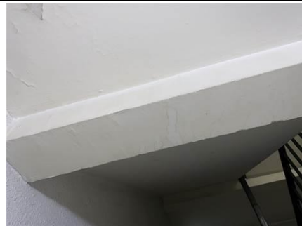
Photo n° PhA673 Localisation : Rez de chaussée - Escalier 1 Ouvrage : Plafond Description : Peinture + enduit blanc + béton gris Localisation sur croquis : 673 Amiante : Chrysotile
