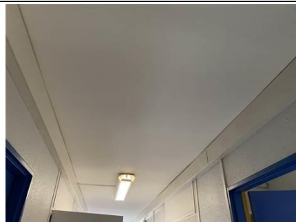
Photo n° PhA176 Localisation : 4ème étage - Dégagement Ouvrage : Plafond Description : Peinture blanche + enduit blanc + béton gris Localisation sur croquis : 176 Amiante : Non détecté
