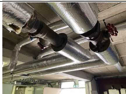
Photo n° PhA699 Localisation : Sous sol Description : Joint de bride fibreux Localisation sur croquis : 700 Amiante : Non détecté
