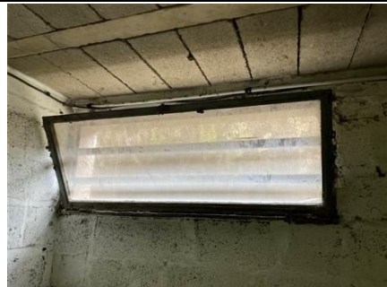
Photo n° PhA696 Localisation : Sous sol Description : Joint dur blanc Localisation sur croquis : 697 Amiante : Non détecté
