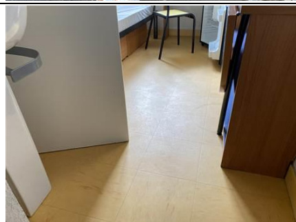
Photo n° PhA012 Localisation : 4ème étage - Logement 421 - Chambre Ouvrage : Sol Description : Dalle de sol souple + colle jaune + ragréage gris + dalle de sol dure rouge + colle noire Localisation sur croquis : 012 Amiante : Chrysotile
