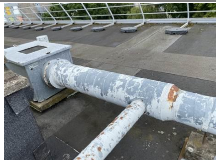
Photo n° PhA011 Localisation : Toit terrasse Ouvrage : Conduit VMC Description : Peinture + colle jaune de joint Localisation sur croquis : 011 Amiante : Non détecté
