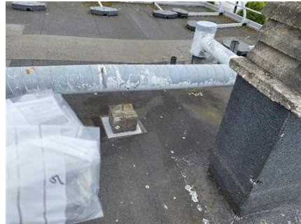
Photo n° PhA009 Localisation : Toit terrasse Ouvrage : Socle conduit VMC Description : Béton gris Localisation sur croquis : 009 Amiante : Non détecté
