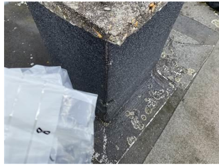
Photo n° PhA008 Localisation : Toit terrasse Ouvrage : Sur cheminée Description : Revêtement bitumineux noir Localisation sur croquis : 008 Amiante : Non détecté
