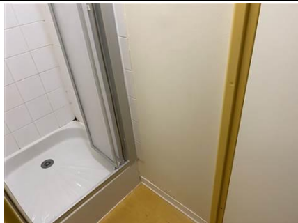
Photo n° PhA497 Localisation : 1er étage - Logement 126 - Chambre Ouvrage : Sol Description : Dalle de sol souple + colle jaune + dalle de sol dure + colle noire + ragréage gris Localisation sur croquis : 497 Amiante : Chrysotile
